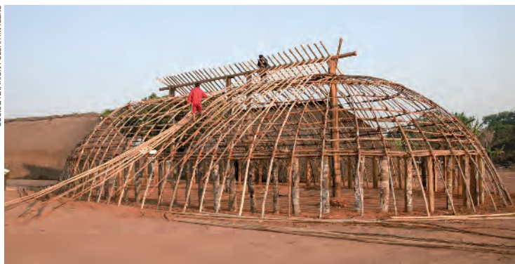
Processo de construção de uma maloca na aldeia Piyulaga, do povo Waurá. Parque Indígena do Xingu, Gaúcha do Norte, estado de Mato Grosso, 2019.
