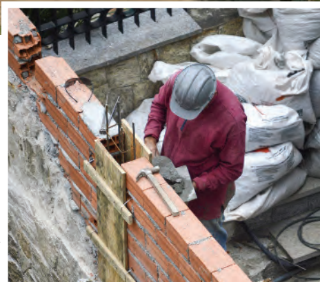
Construção de muro de alvenaria com blocos de tijolo e cimento. São Paulo, estado de São Paulo, 2018.
