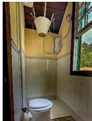
Chuveiro de água quente da casa de Santos Dumont. Petrópolis, estado do Rio de Janeiro, 2025.
