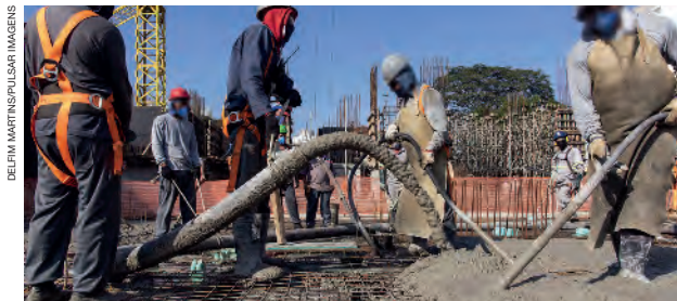
Concreto sendo utilizado na construção da laje de uma moradia no município de São Paulo, no estado de São Paulo, em 2021.
