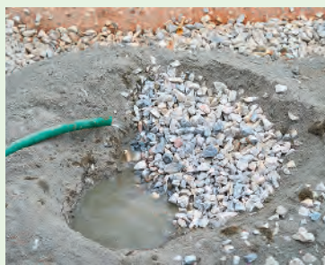
Mangueira despejando água sobre cimento e brita.
