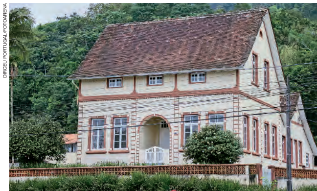
Construção em estilo influenciado pela arquitetura alemã na cidade de Pomerode, no estado de Santa Catarina, em 2024.
