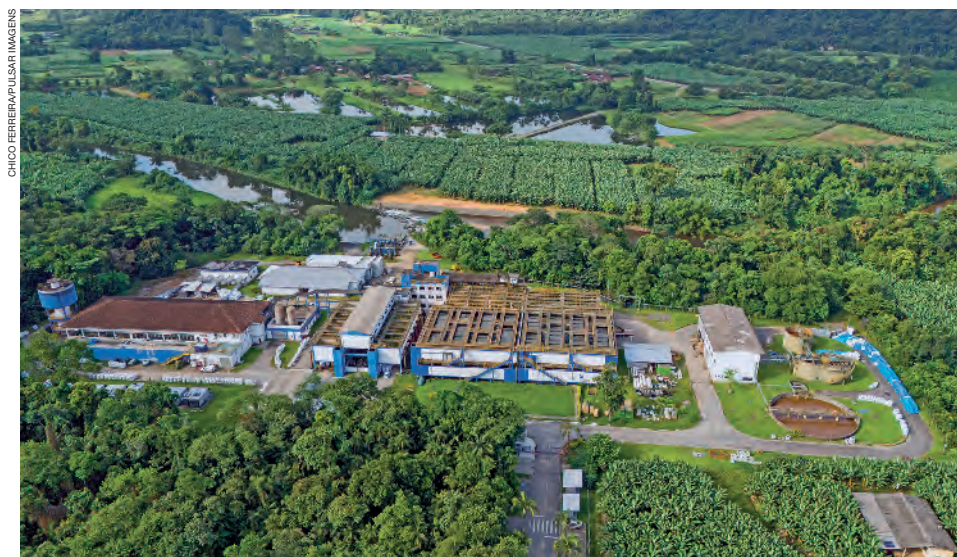
Estação de tratamento de água no município de Joinville, no estado de Santa Catarina, em 2025.
