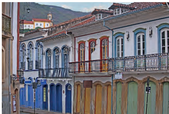
Construções do período colonial no município de Ouro Preto, no estado de Minas Gerais, em 2022.
