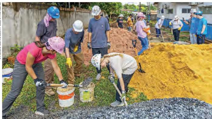
Mutirão para ampliação de Unidade Básica de Saúde, no município de Santarém, no estado do Pará. Fotografia de 2025.
