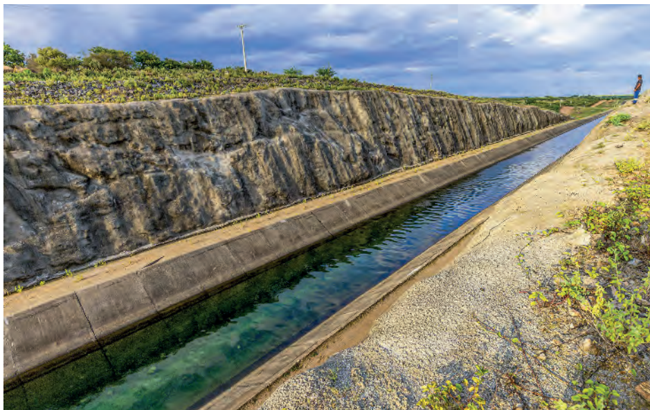
Canal artificial construído para levar água do Rio São Francisco a áreas do Semiárido no município de Custódia, no estado de Pernambuco, em 2025.
