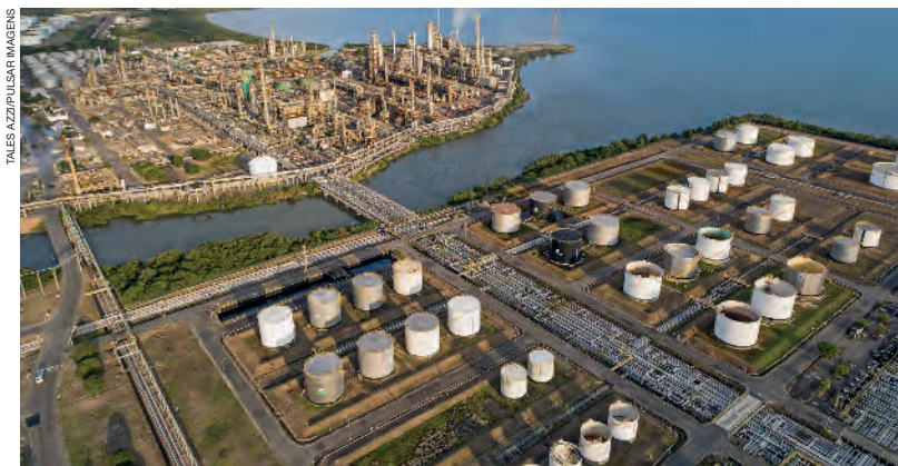
Estruturas de refinaria de petróleo no município de São Francisco do Conde, no estado da Bahia, em 2021.
