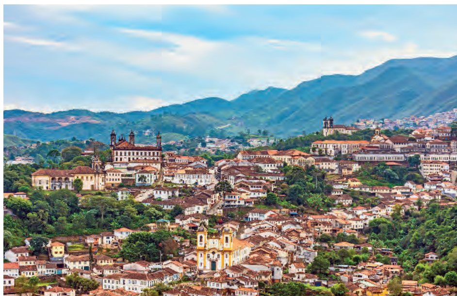
Vista de parte da cidade de Ouro Preto, no estado de Minas Gerais. Fotografia de 2024.
