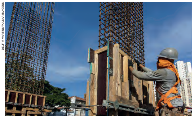
Operário do setor da construção civil trabalhando em uma obra em São Paulo, no estado de São Paulo. Fotografia de 2021.
