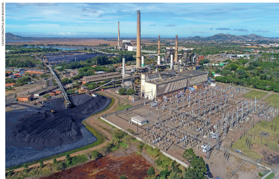
Vista do Complexo Termoeletrico Jorge Lacerda, no município de Capivari de Baixo, no estado de Santa Catarina. Fotografia de 2021.
