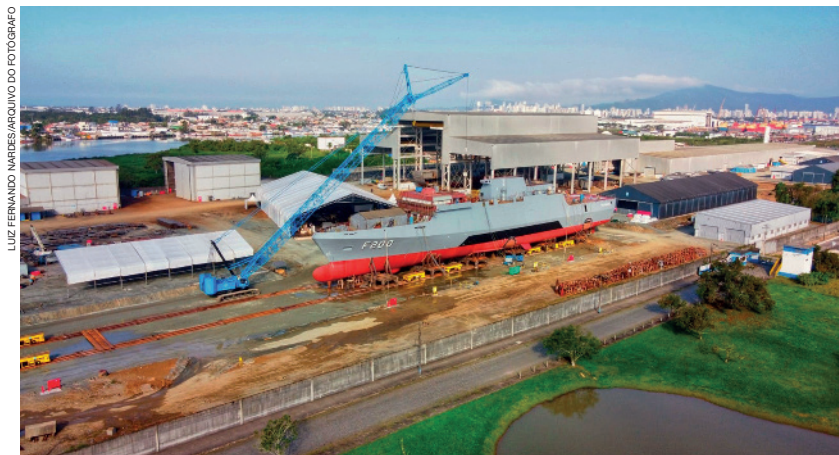
Vista de um estaleiro na cidade de Itajaí, no estado de Santa Catarina. Fotografia de 2024. O estaleiro é uma instalação industrial especializada em construção de embarcações.
