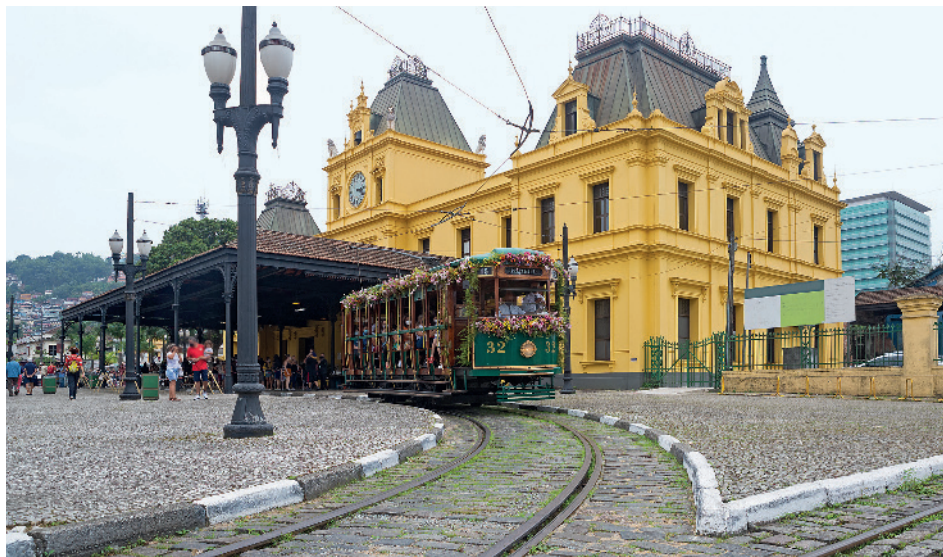
Bonde elétrico no município de Santos, no estado de São Paulo. Fotografia de 2021.
