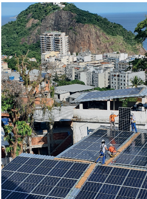
REVOLUSOLAR/INSTALAÇÃO USINA ADALBERTO ALMEIDA, JULHO 2024
