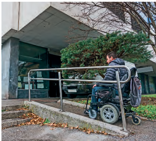
Rampas de acessibilidade são importantes para promover inclusão.
