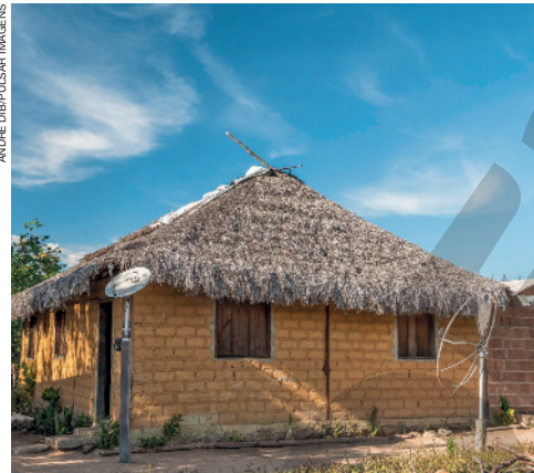
MORADIA NO MUNICÍPIO DE CAVALCANTE, NO ESTADO DE GOIÁS, EM 2020.
