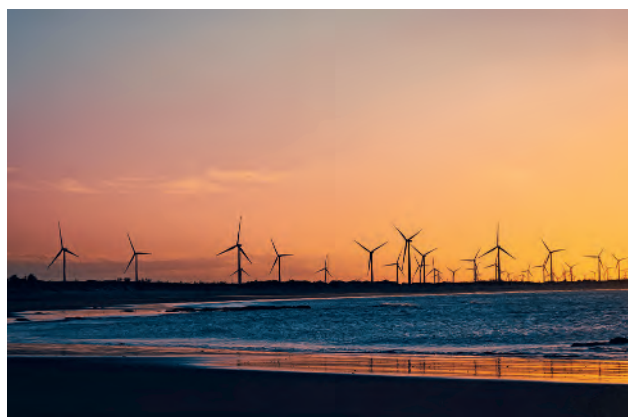
Vista de um parque de turbinas eólicas no Rio Grande do Norte, em 2021.
