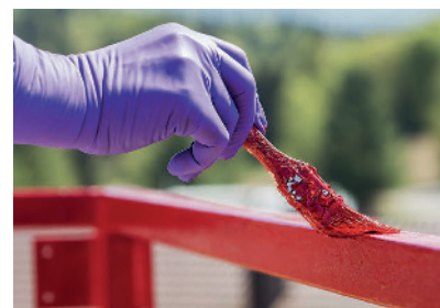
Figura 16. Revestir o ferro com tinta (que forma uma camada polimérica que adere ao metal) inibe o enferrujamento porque impede o contato do metal com o gás oxigênio e a água.
